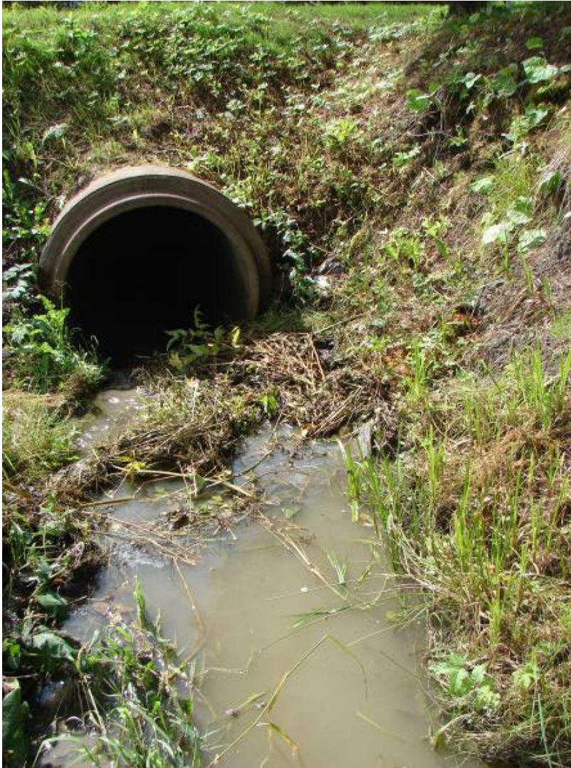
Kuva 10. Muuralanpuron alaosassa oli ennen Kirkkopuistontietä leikattua heinää mikä muodosti paikoin tulppia vedenkululle.
